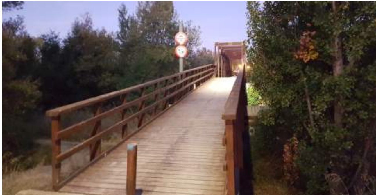
Imagen de la pasarela sobre el río Gállego
