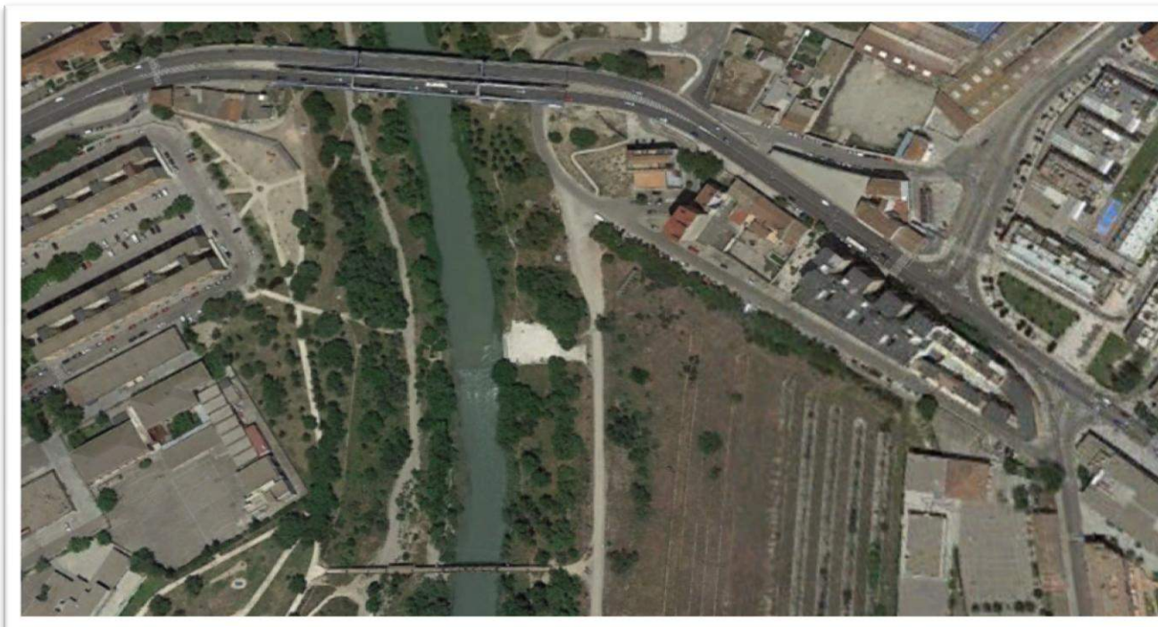
Imagen aérea en donde vemos los puentes para vehículos y la pasarela peatonal y ciclable
